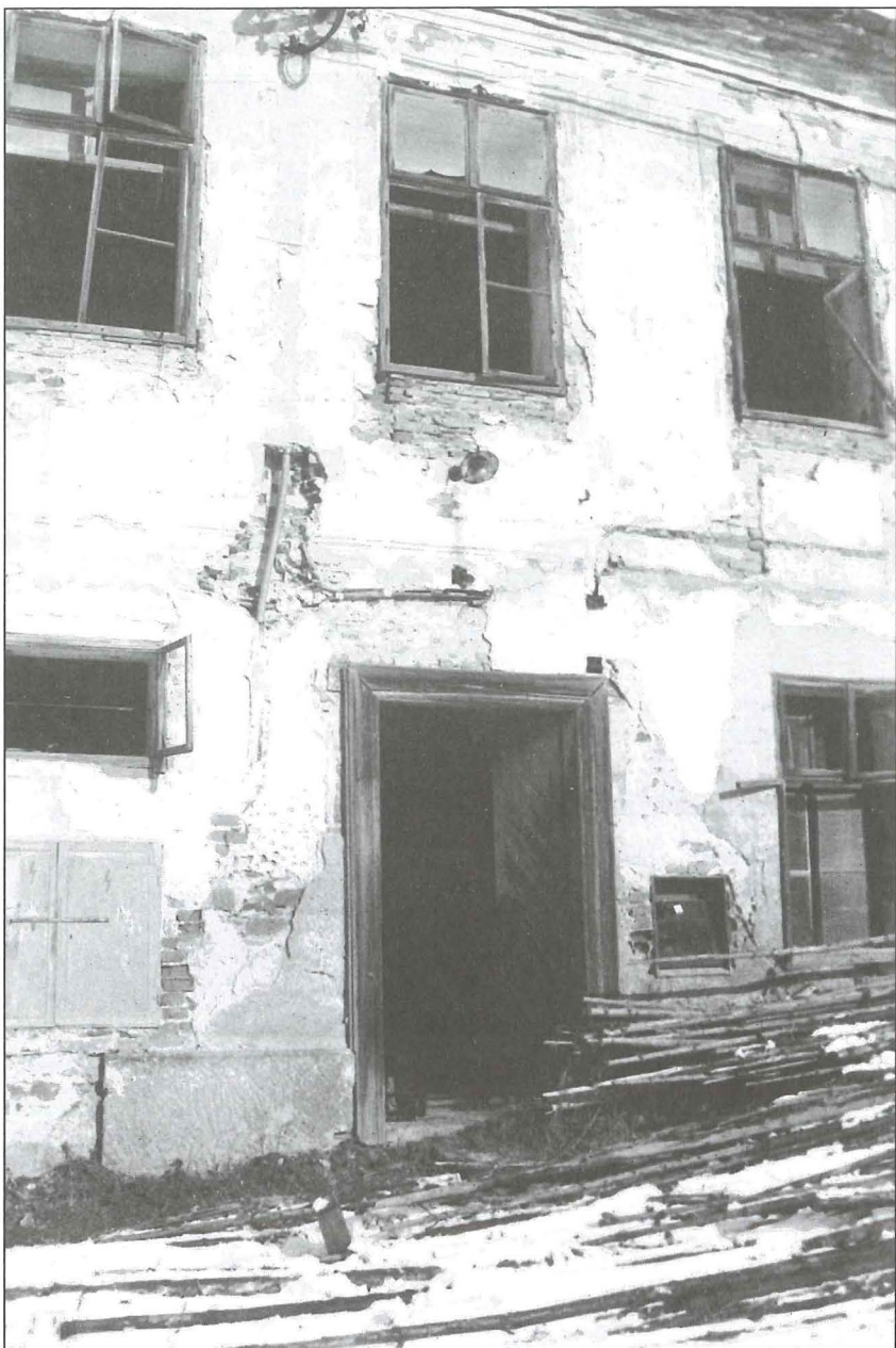
Obr. 6. Petrovice (okr. Benešov), hlavní vstup do zámku v jižním průčelí. Stav 13. ledna 2001, foto autor.
