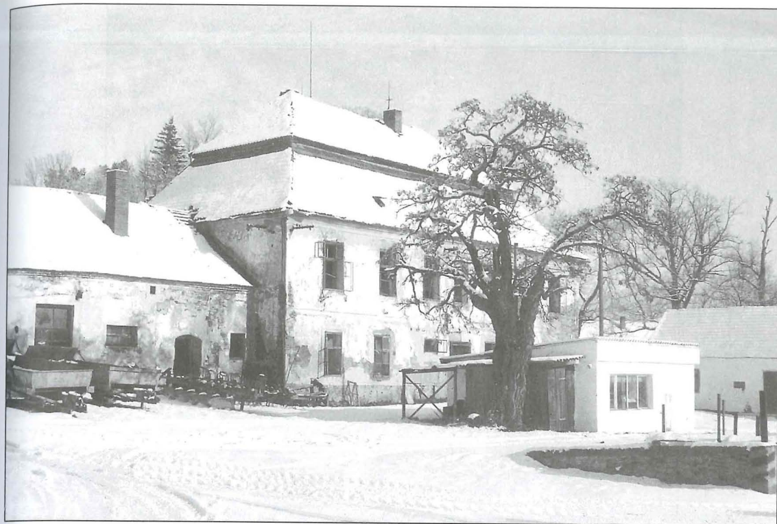
Obr. 5. Petrovice (okr. Benešov), zámek od jihozápadu z prostoru dvora. Stav 13. ledna 2001, foto autor.
