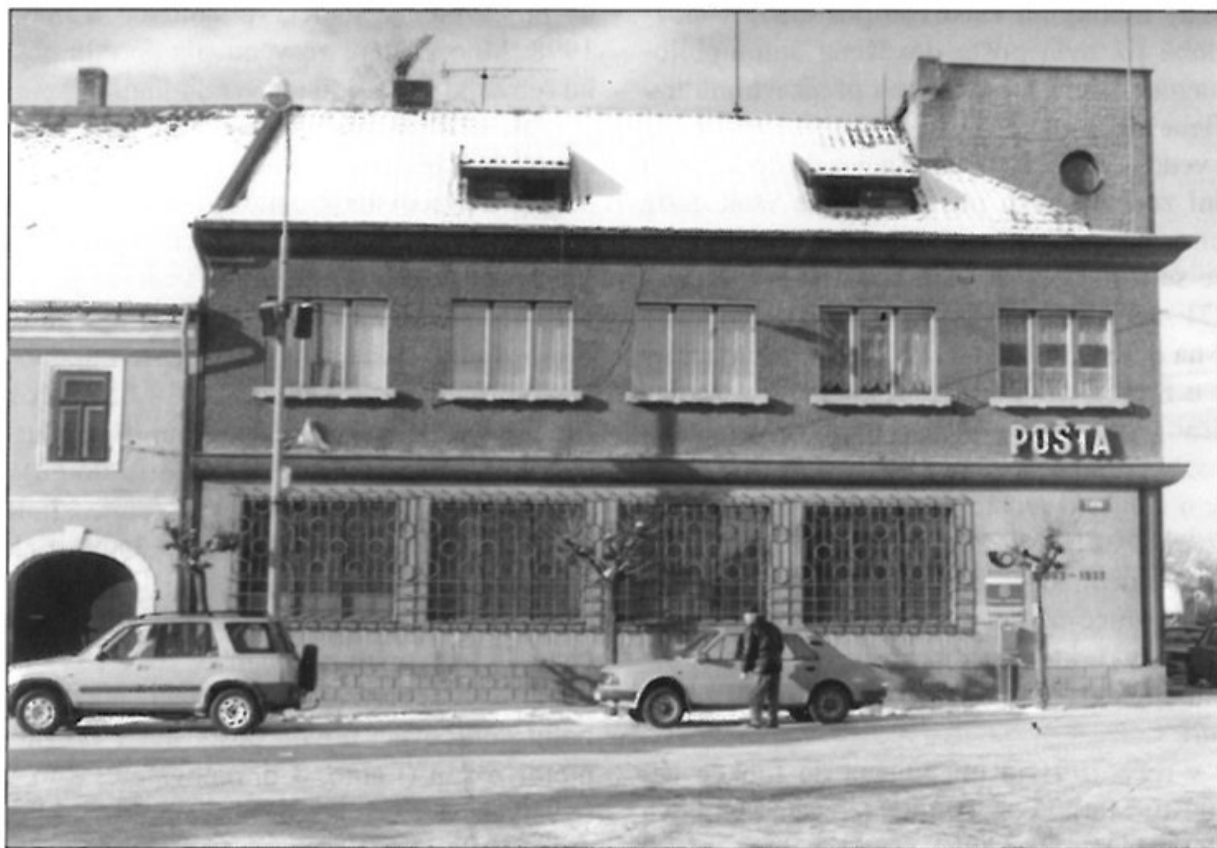
Dům číslo 65 v Sedlci-Prčici – sídlo pošty od roku 1949 dodnes (stav v r. 2000).
