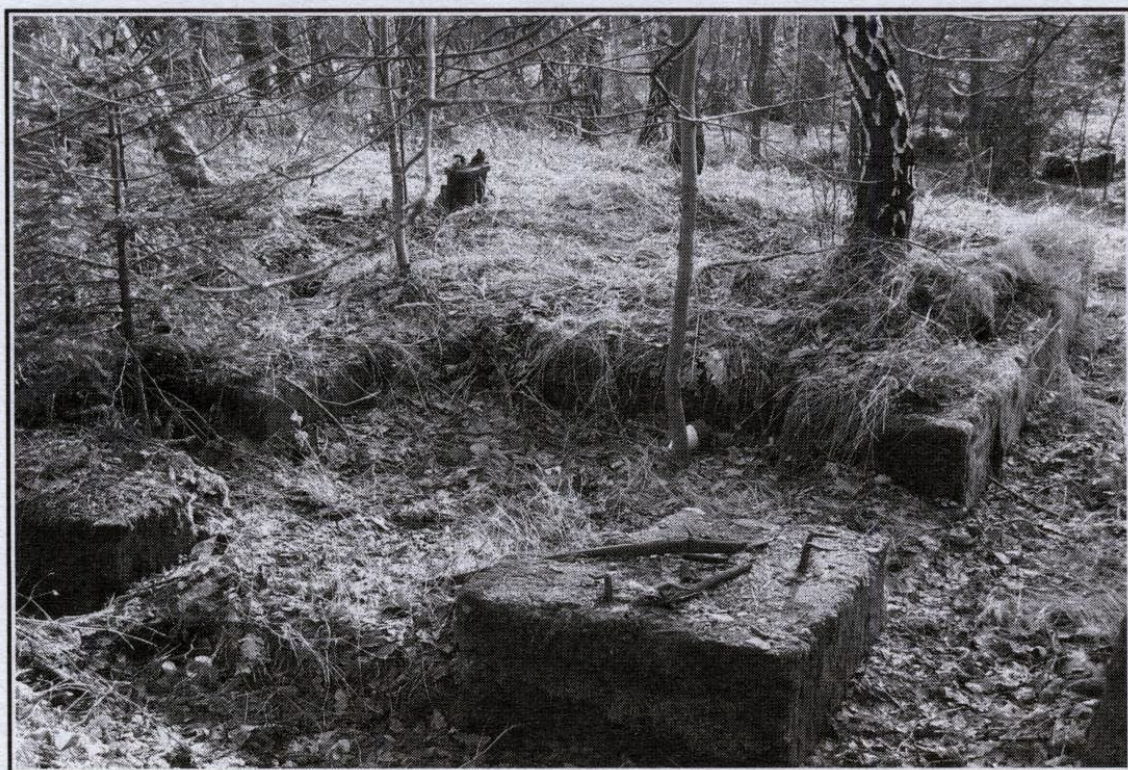
Zbytky základů zřejmě těžní věže – foto L. Doubravová, leden 2011
