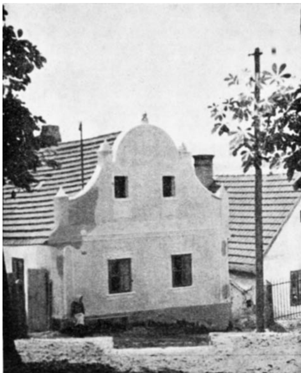
Štítový dům čp. 77 v Borotíně Foto Ing. R. Cikhart
